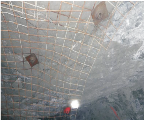
图 5 顶部锚杆锚网支护形式
