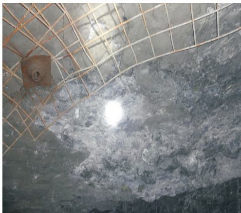
图1 采区现场顶部岩体破坏现状
